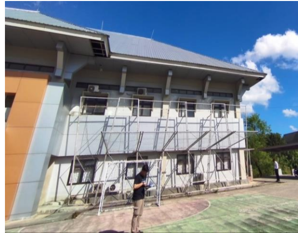
Gambar 1. Tampak sisi timur gedung kuliah (ruang dosen lantai 1).
