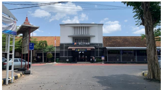
Gambar 6. Fasad Bangunan Stasiun Blitar Saat ini. Sumber: Dokumen Pribadi, 2024
