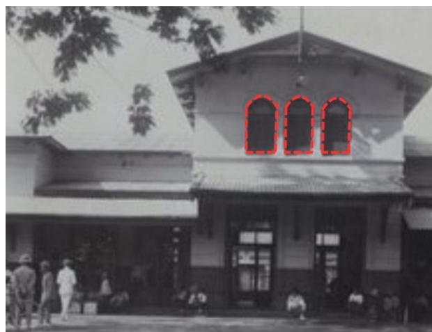
Gambar 3. Jendela pada Fasad Bangunan Stasiun Blitar Sumber: Analisis Pribadi, 2024
