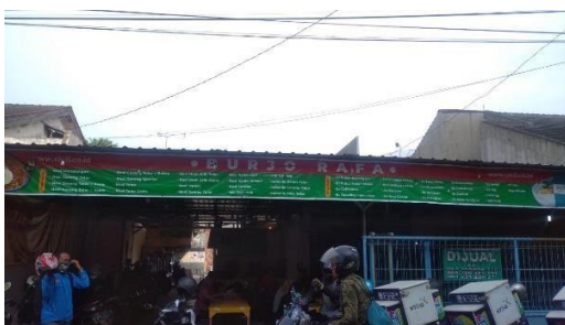
Gambar 1. Kondisi Bangunan dan Situasi Sumber: Dokumen Pribadi
