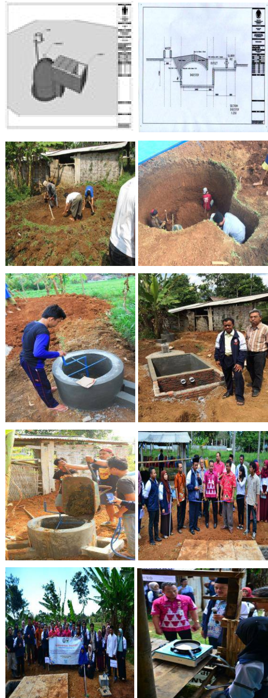
Gambar 1. Ilustrasi Kegiatan Gambar Desain, Pembangunan Instalasi Biogas, Pengisian Digester, Uji Coba Kompor Biogas, dan Peresmian Instalasi Biogas
