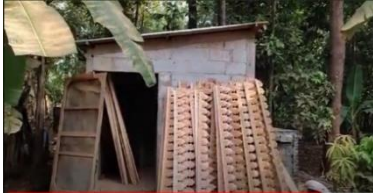
Gambar 5. Ruang Oven yang Baru
